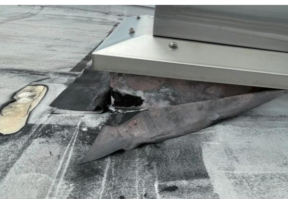
剥がれはシートの乾燥、雨風の影響や経年劣化により防水加工が剥がれひび割れや小さな亀裂が発生している状態。
