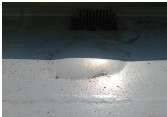
屋上防水の浮きは経年劣化によって下地と防水シートの密着が悪くなっている状態。
