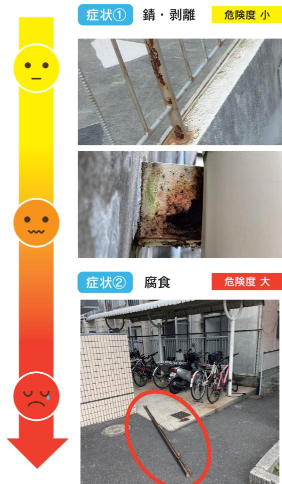
塗膜の剥離は経年劣化により樹脂の結合力が低下し下地と塗膜の接着力が弱まっている状態。腐食は、経年劣化等の原因により露出した鉄部が錆びて腐っている状態。
