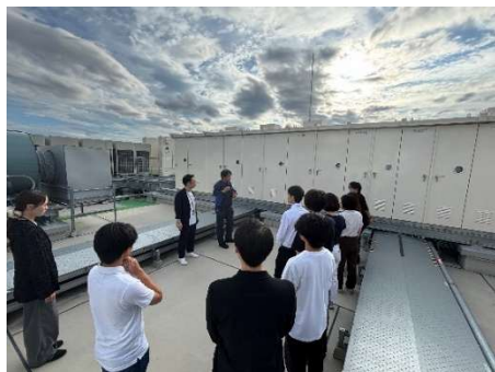
屋上空調・機械設備
